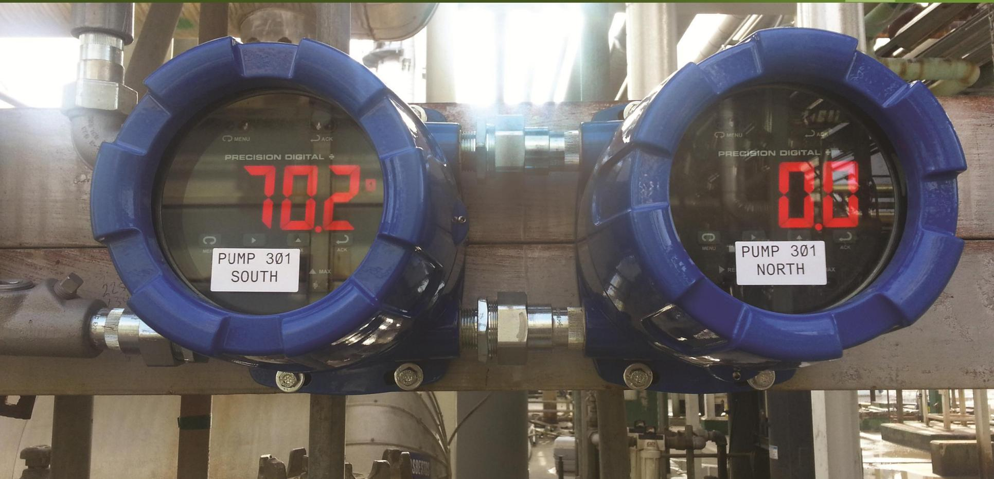
Controlador de bombas a prueba de explosión con pantalla gigante y control de alternación de bombas
